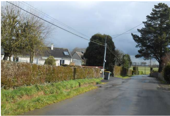
L'Ouche / un habitat individuel implanté le long de la Route de L'Ouche
