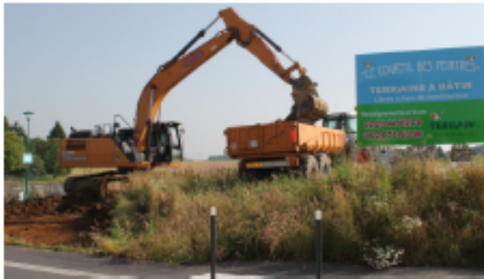
Les premiers coups de pelle ont été donnés le 27 juin dernier. Les travaux se termineront après l'été.
